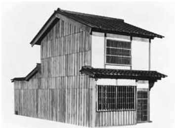
1 階は工場 現大阪市福島区大開町 パナソニックミュージアム内に再現 図 4 創業の家
