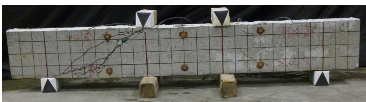
図.6 実験供試体のひび割れ状況(健全)
