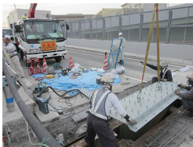
新しい構造の床版連結施工 (土木施工 2014 Jul VOL.56 No.7より)
