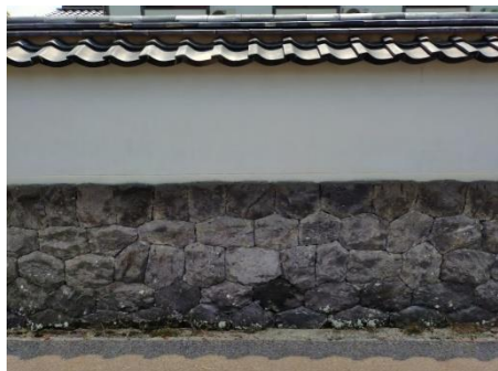
写真三 進行方向左（南）の垣壁塀
