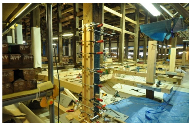
炭素繊維による柱の根継補強
