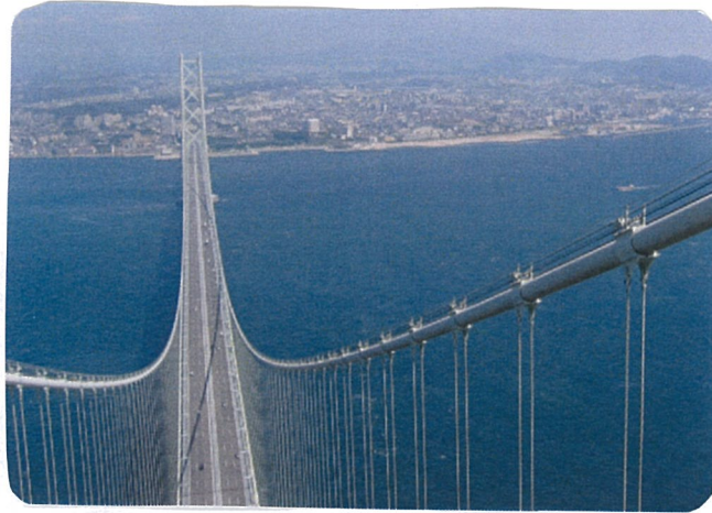
明石海峡大橋（神戸から淡路に向かって、撮影：Geralt Siebert）
