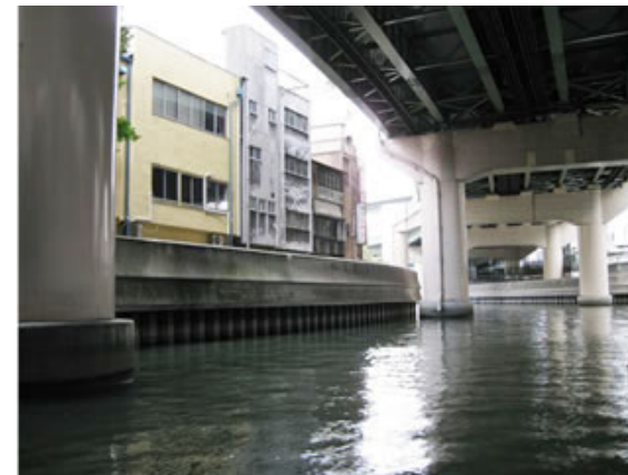
東横堀川 堀川の多くは埋め立てられたが、阪神高速道路の高架橋が架けられた川もある。垂直護岸が連続して親水性がなく、川に背を向けた建物が多い。
