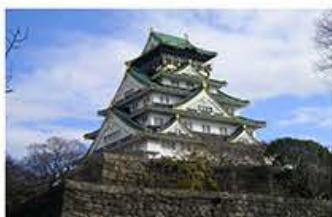
文化遺産など足場を組めないものの検査に活用
