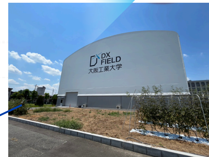
屋外フィールド（囲場） (幅10m×奥行25m)
