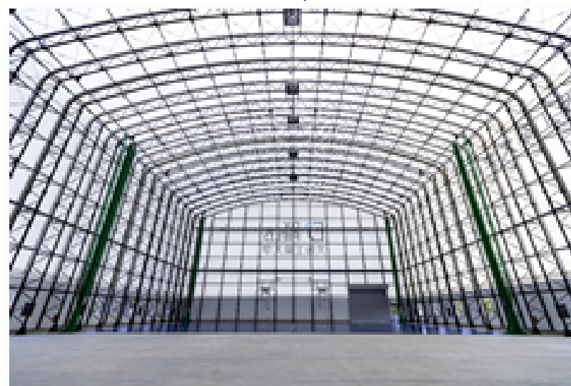
西側半面（コンクリート床）
